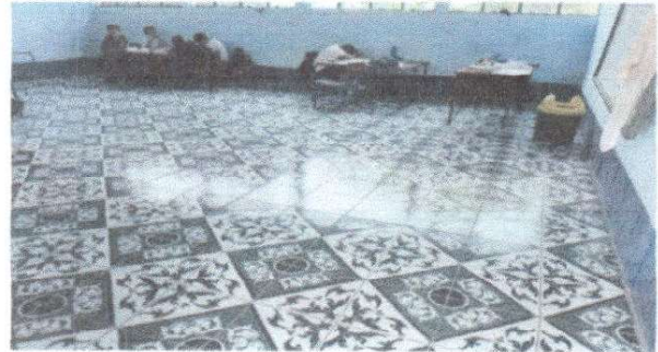
Foto 2: Cambio de piso por piso cerámico
