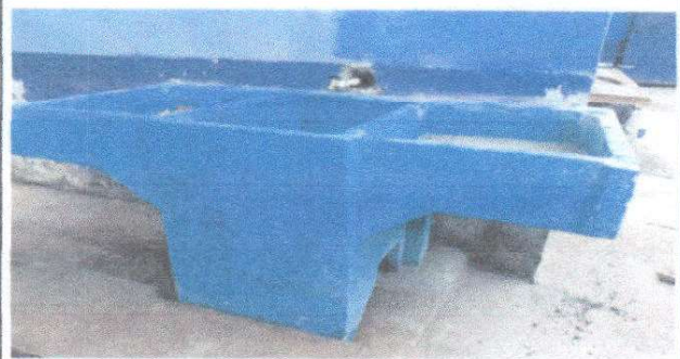
Foto 4: Cambio de pila
