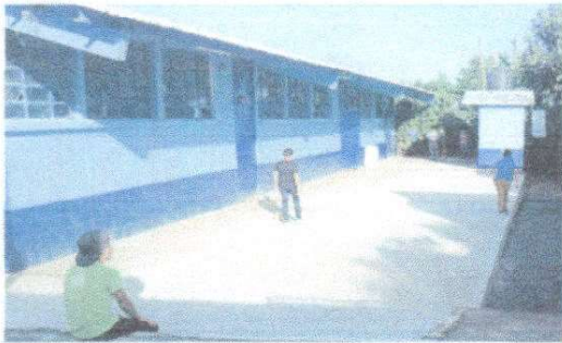
Foto 1: Reparación de patio
