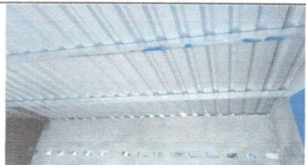
Foto 6: Cambio de costaneras y láminas de cocina
