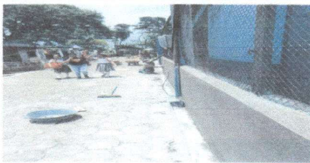
Foto 5: Repello de muro perimetral
