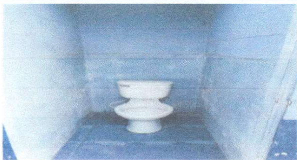
Foto 3: Cambio de fosas sépticas por sanitarios lavables
